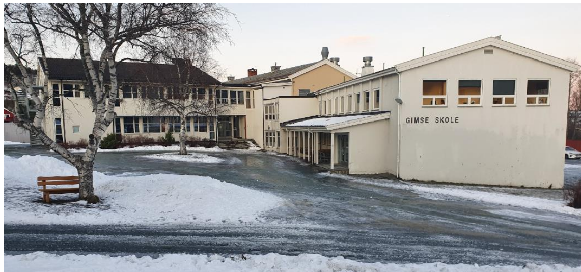
Bilde sørlig del av eksisterende Gimse skole.
